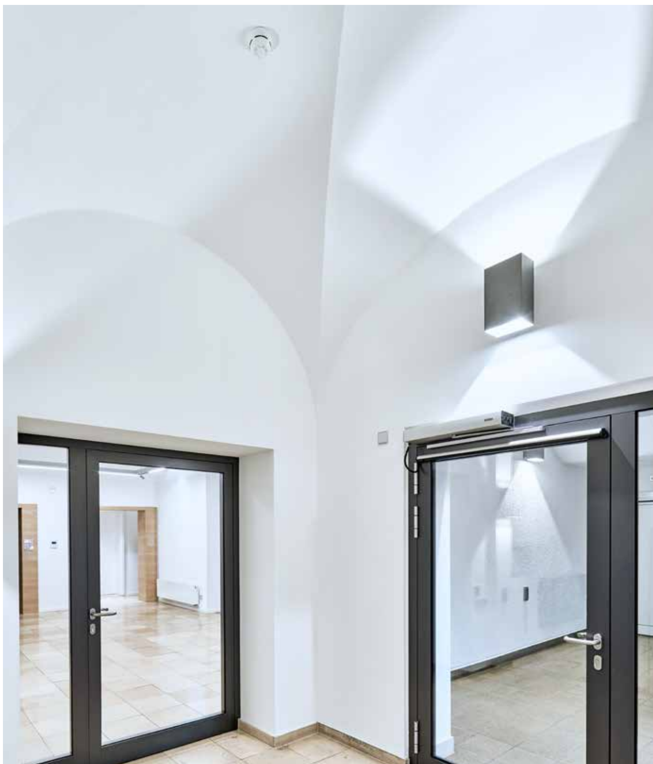
Einbausituation (Foto: Annika Feuss / GEZE GmbH)
