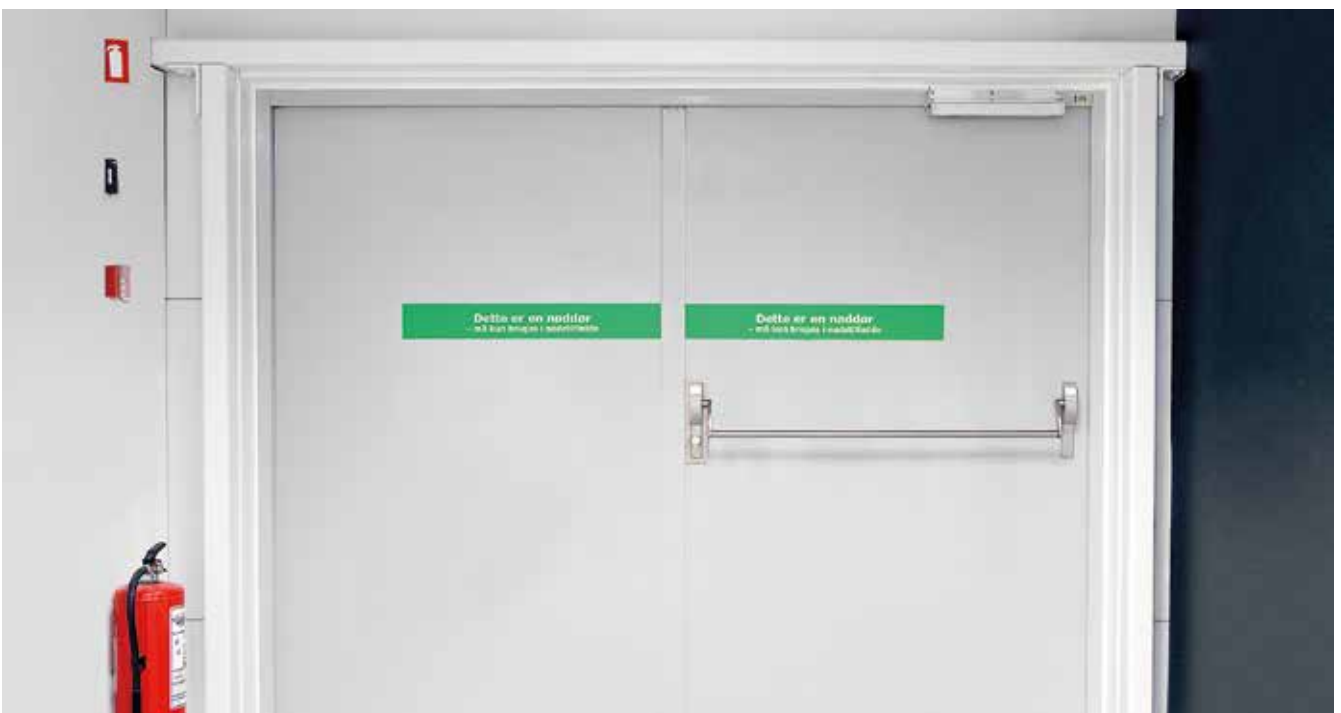
IKEA, Taastrup, Denmark (photo: Morten Bak / GEZE GmbH)
