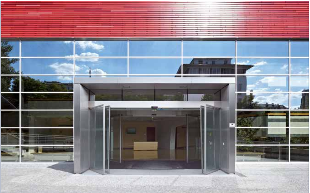
Auditorium centre Klinikum rechts der Isar, Munich, Germany (photo: Robert Sprang)
